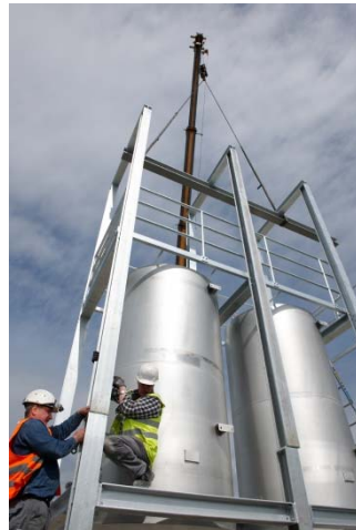
Traitement par charbon actif
